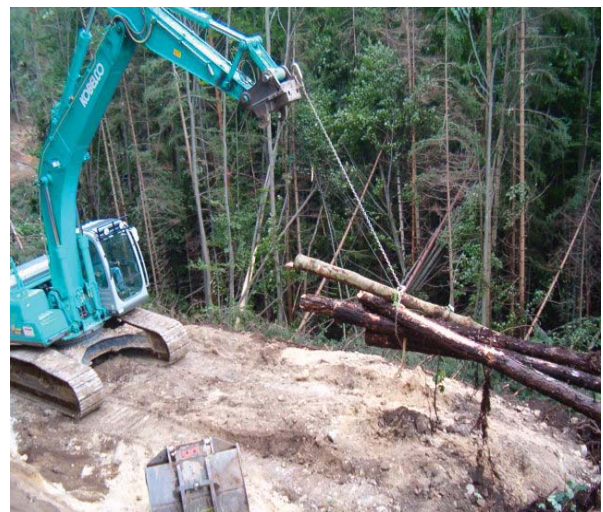
Fig. 5. Degajarea vegetației lemnoase Excavator depositing logs
