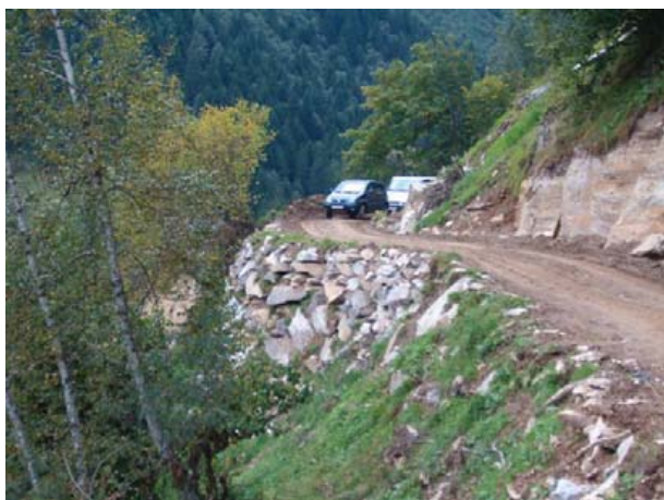
Fig. 8. Anrocamente la rambleu Anrocments at fill
