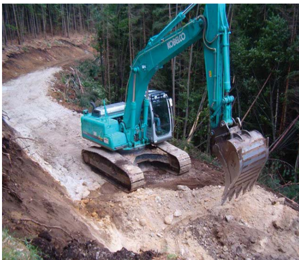
Fig. 4. Excavator în funcționare normală Excavator working normally
